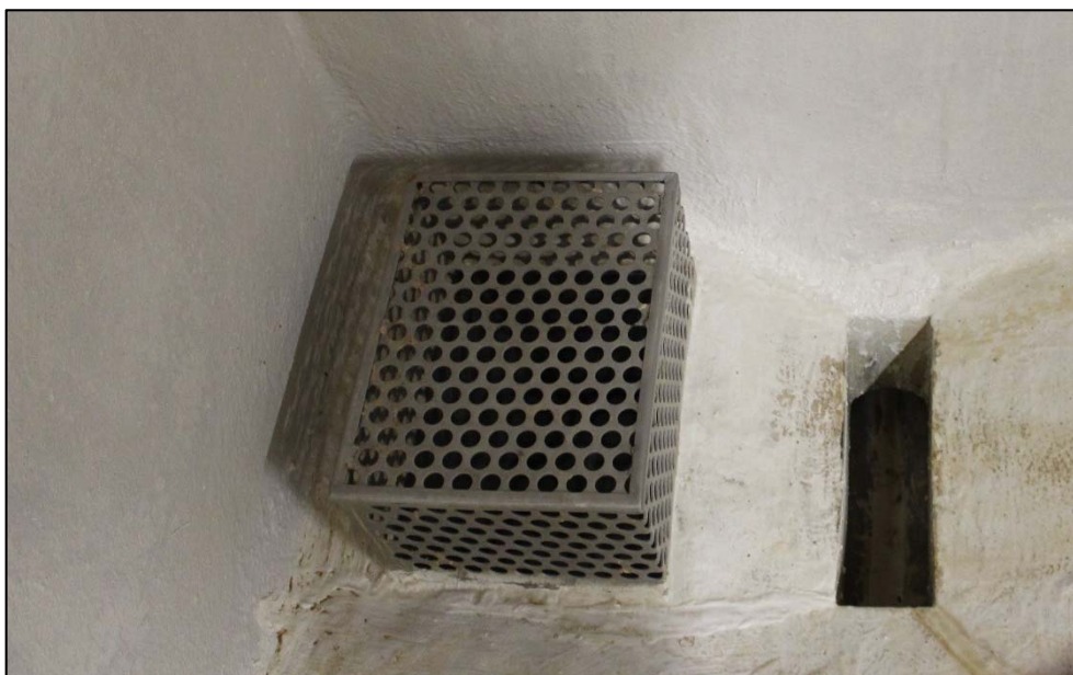
Figure 12 - Réservoir d'En Cheseaux - Crépine de départ et fente de vidange
