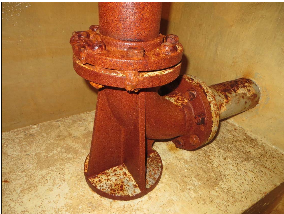
Figure 5 - Réservoir des Faverges - Corrosion sur pièce immergée
