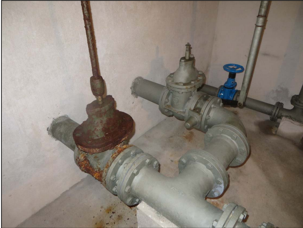
Figure 4 - Réservoir des Faverges- Corrosion sur vannes
