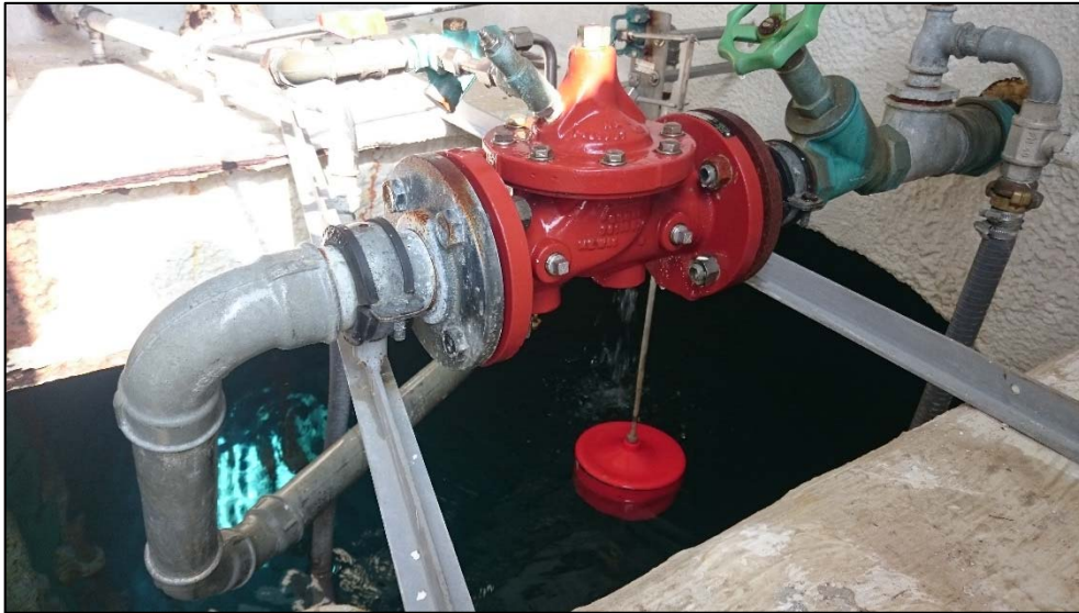
Figure 9 - Réservoir des Faverges inf. - Vanne à flotteur
