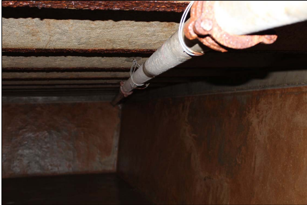
Figure 7 - Réservoir des Faverges inf. - Intérieur de la cuve, corrosion sur profilés
